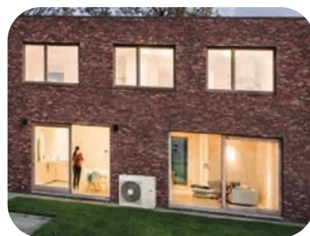
Maison avec unité extérieure
