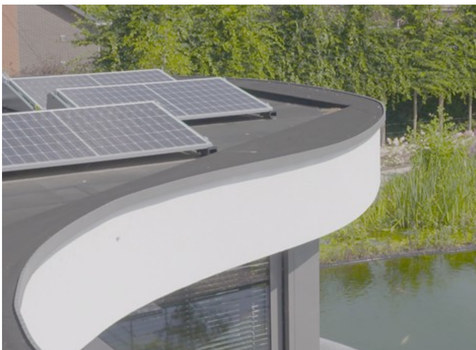
De verwarming van een grote vijver en een koelinstallatie met 8 binnenunits zorgt voor een hoog elektriciteitsverbruik in dit project
