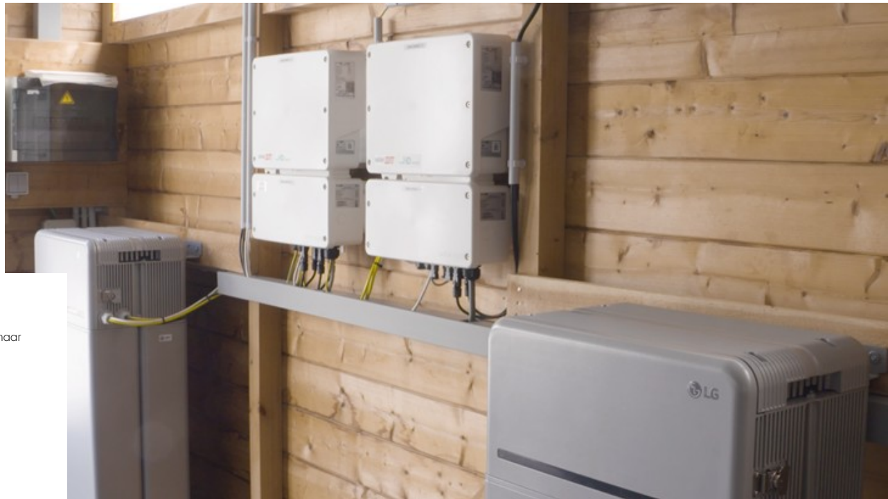
Omvormer van SolarEdge & LG Chem-batterij
