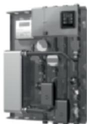
HIU est une unité pour le réglage du chauffage par le biais d'une vanne de zone, l'équilibrage hydraulique de l'installation ainsi que la régulation de la production d'eau chaude sanitaire suivant les équipements dont elle est pourvue.
