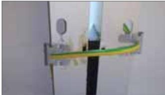
Agrafes auto-dénudantes pour réaliser la liaison équipotentielle entre un câble de terre et le cadre aluminium du panneau photovoltaïque selon les préconisations du guide UTE 15-712-1. Les griffes pénètrent sous la couche d'anodisation du cadre et les bords intérieurs de l'agrafe perforent l'isolant pour assurer un contact optimal avec le cuivre du fil de terre.
