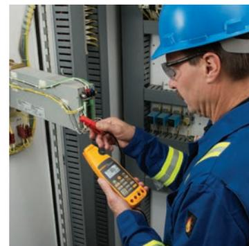
Mesurez les signaux de process et d'autres automatisations de 4 à 20 mA sans déconnecter la boucle.
